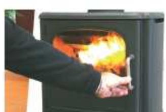
5. Žhavou vrstvu pohrabáčem rozprostřete po dně spalovací komory (v přední části komory by měla být vrstva silnější).
